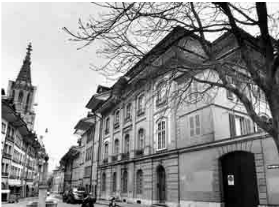
Das Haus an der Herrengasse 23: die Nordfassade ...
