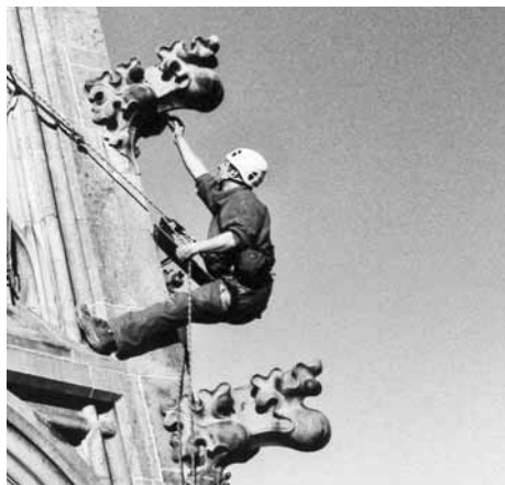
Nur für Schwindelfreie: Kontrolle einer Sandsteinkrabbe am Berner Münster. (Foto: Hansueli Trachsel)
