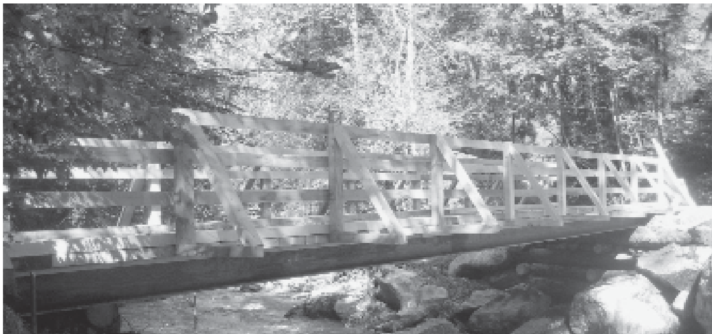
... und mit der neuen Chlosnerenbrücke nach der Sanierung. (Fotos: Martin Hauert).
