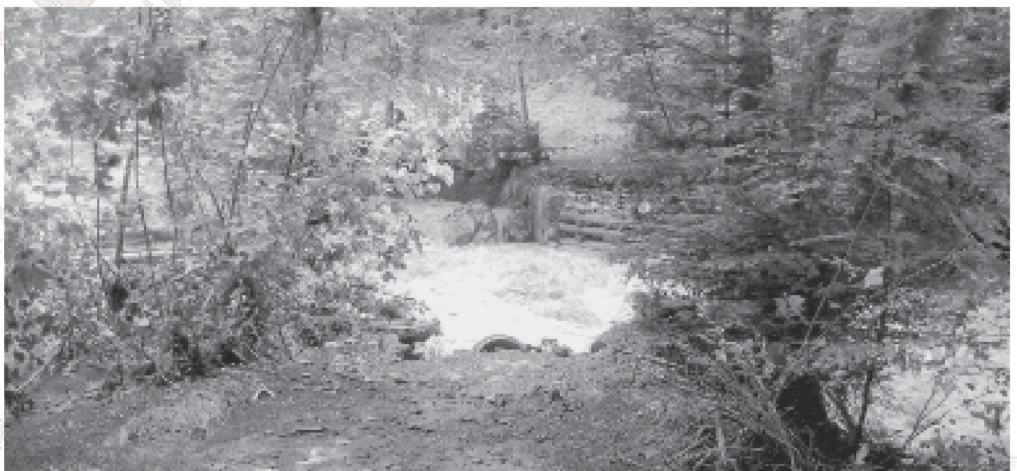
Das Gornerenwasser, «brückenlos» nach den Unwettern...
