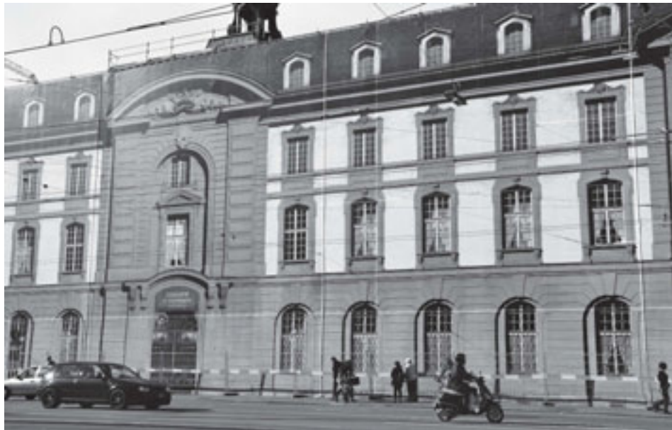
Bereit für den grossen Umbau – das Burgerspital in neuem Kleid (Fassadenverkleidung)
