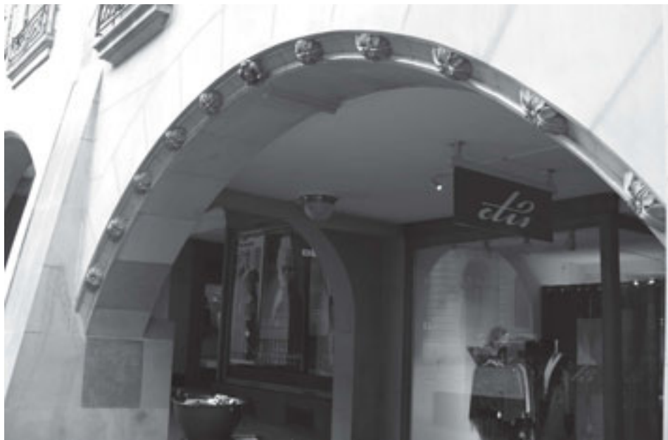
Laubenbogen mit Sandsteinrosetten.
