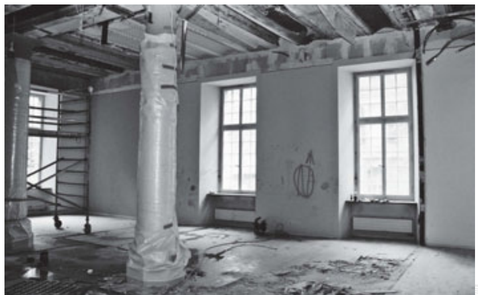
Der Rückbau im Burgerspittel hat begonnen
