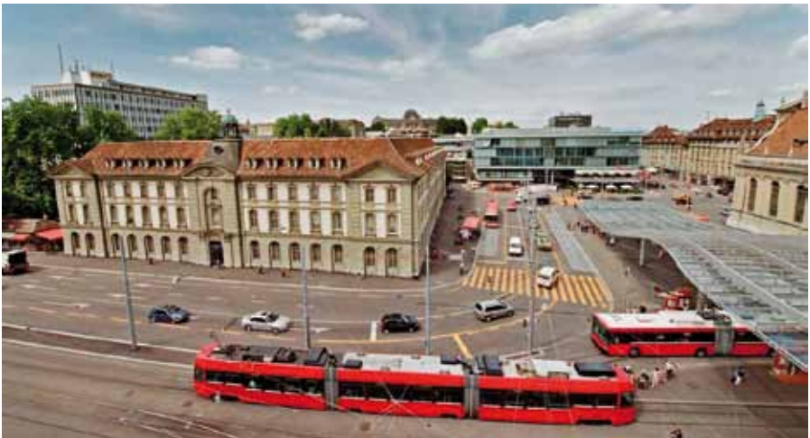
Blick auf den neu gestalteten Bahnhofplatz (Foto: Hansueli Trachsel)
