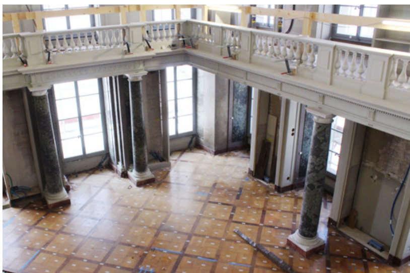
Parkettarbeiten im Hallersaal
