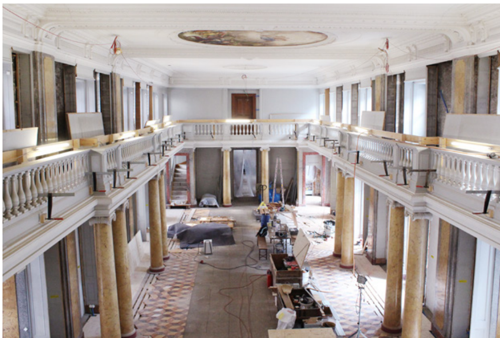
Die Burgerbibliotheksbaustelle Ende November, hier der Schultheissensaal
