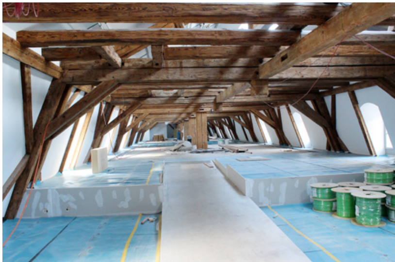
Die neu konzipierten Arbeitsräume im Dachbereich
