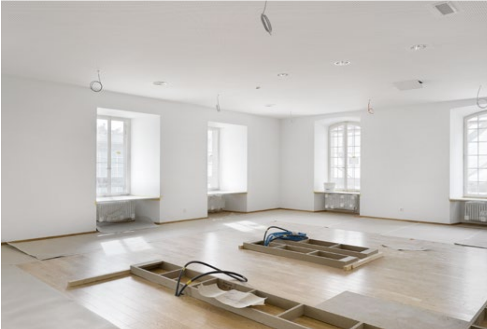
Baustelle mit einem der drei künftigen Aufenthaltsräume samt zentraler Wohnküche der Hausgemeinschaften «Wohnen im Alter» im zweiten Obergeschoss des Berner Generationenhauses.
