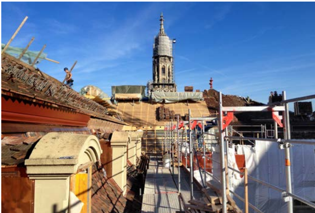
Auch der Dachbereich des Bibliotheksgebäudes wurde komplett saniert sowie baulich angepasst.
