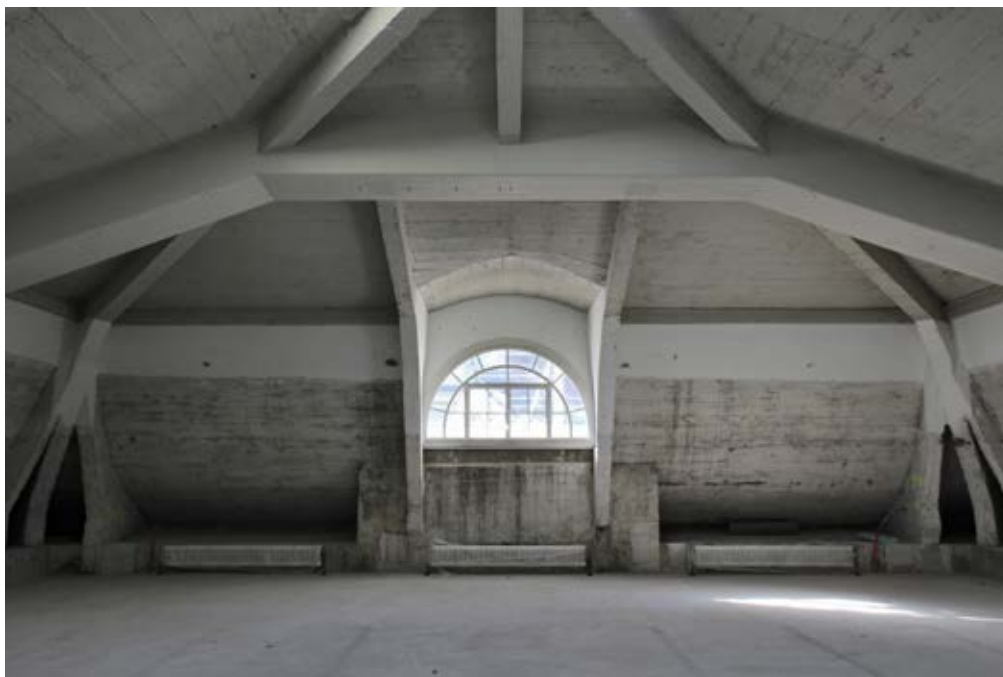
Künftiges Restaurationsatelier im Dachraum des Westflügels.
